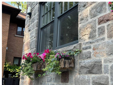
Arrière du bâtiment
